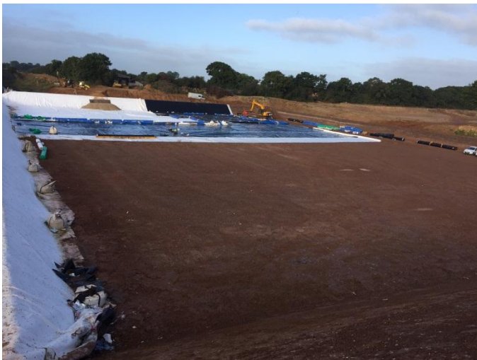
Pose géomembrane et géotextile anti poinçonnement
