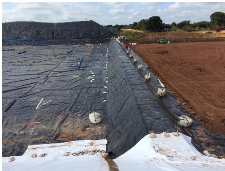
Pose géomembrane et géotextile anti poinçonnement
