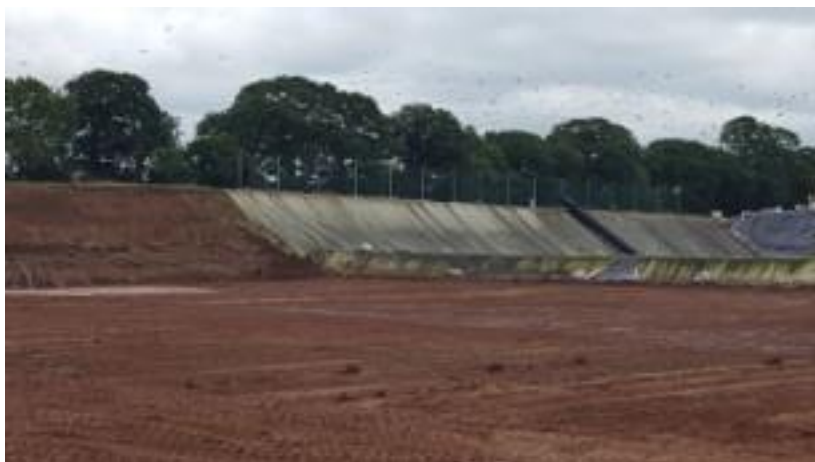
Mise en place argile 10^{-9} \text{ m.s}^{-1} C10 pour BSP
