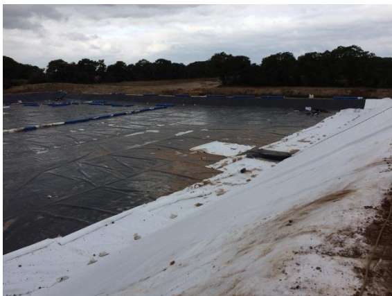
Pose géomembrane et géotextile anti poinçonnement
